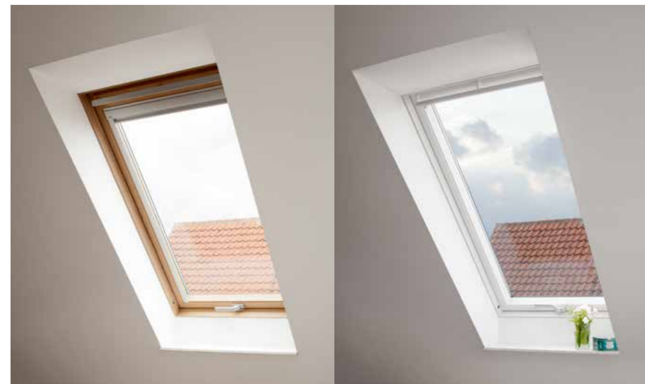
Gootstukken en installatie
